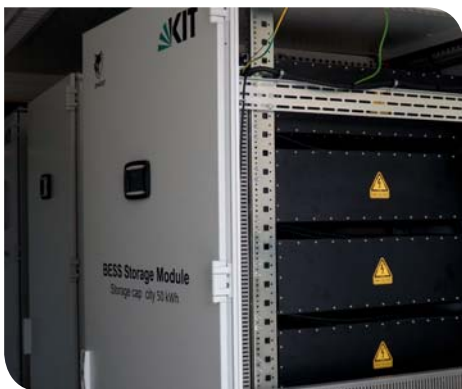
Sicheres, modulares Batteriesystem auf Basis hochwertiger Lithium-Ionen-Zellen
