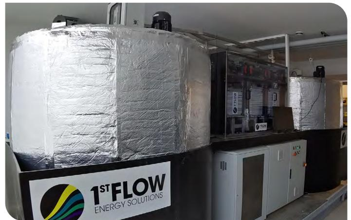
Vanadium-basierte Redox-Flow-Batterie mit Isolierung. (KIT/Felix Schofer)
