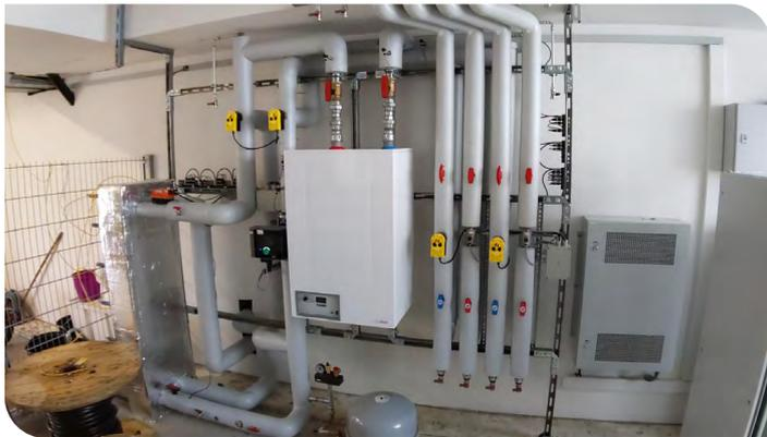
Thermisches Koppelmodul mit Heizelement und Wärmetauscher für die Warmwasserversorgung. (KIT/Felix Schofer)
