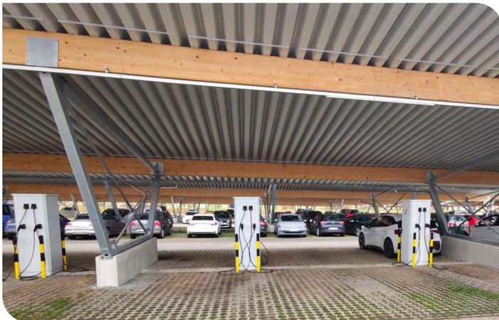
Abbildung 1: Demonstratoranlage in Schwieberdingen bei der Robert Bosch GmbH. Zu sehen sind die 12 DC-Ladepunkte und das Display zur Eingabe der Parkdauer. (Bild: Alexander Stein)
